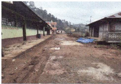
Foto 3: Sustitución de planchas de concreto de patio
