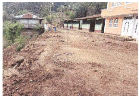
Foto 4: Sustitución de planchas de concreto de patio
