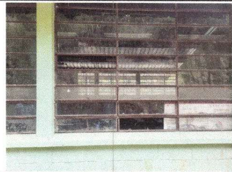
Foto 2: Sustitución de vidrios
