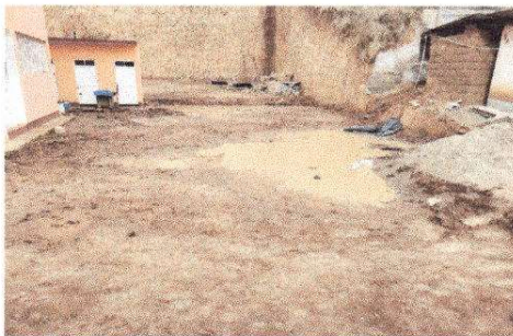
Foto 5: Sustitución de planchas de concreto de patio
