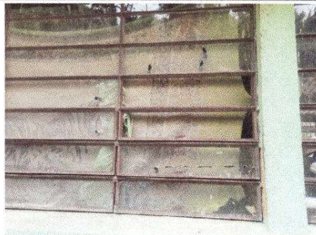
Foto 1: Sustitución de vidrios
